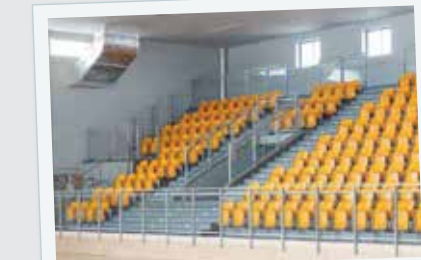
Hala w Skawinie po remoncie
