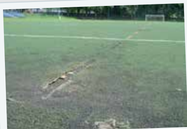
Boisko MORiS w Chorzowie przed remontem
